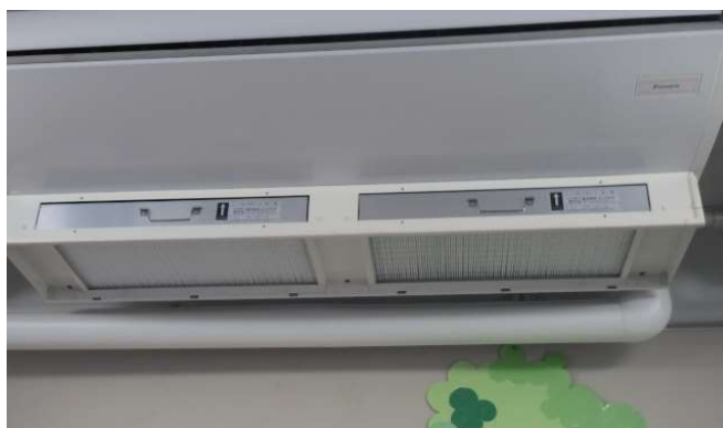
超親水性持続抗菌フィルター設置
